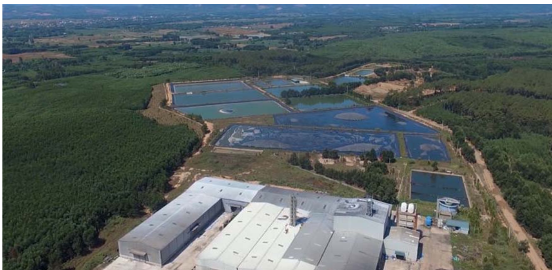
Toàn cảnh hệ thống xử lý nước thải của Nhà máy chế biến tinh bột sắn Cam Lộ.
