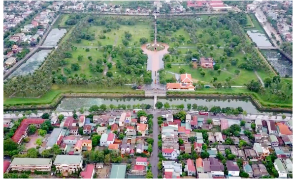
Hình 4. Toàn cảnh Thành cổ Quảng Trị (Ảnh UAV)
